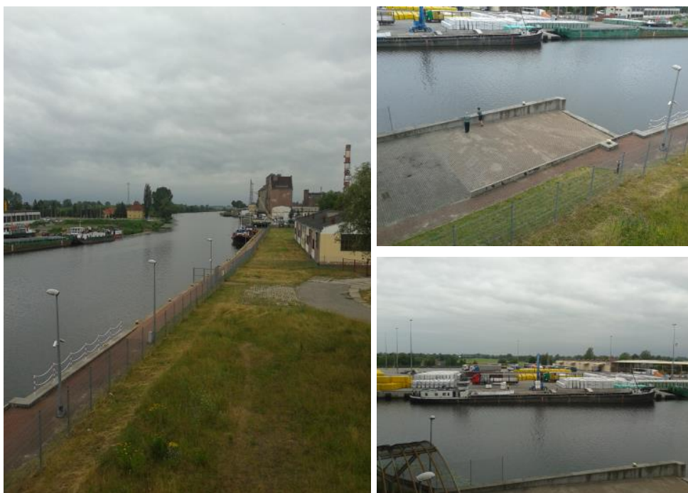
Rysunek 4. Widok na tereny terminalu pasażerskiego ZMPE (w tle widoczny elewator zbożowo-paszowy) oraz rampę ro-ro (prawa góra). Po prawej na dole – prace przeładunkowe na terminalu towarowym ZMPE
